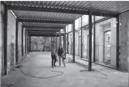
Nueva sede del Museo en obras. Planta baja.
