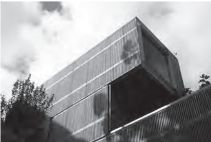
Nueva sede del Museo. Acceso principal ya habilitado y funcional.
