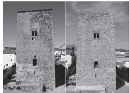
Torre del homenaje. Comparativa de la intervención.
