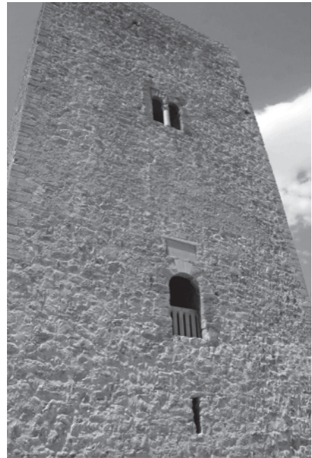
Torre del homenaje. Aspecto final.
