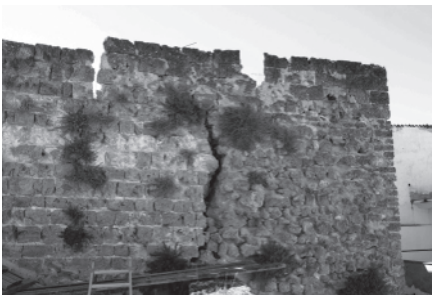
Detalle de la unión del Lienzo 1 con la Torre 1-7 (al interior), muy afectada por la sismicidad histórica.
