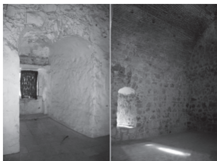
Torre del homenaje. Comparativa de la Planta Segunda, con ventana aspillerada medieval recuperada.
