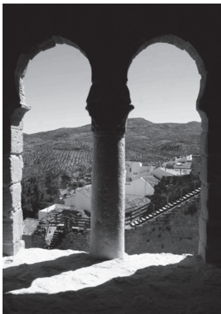
Torre del homenaje. Aljimez consolidado.
