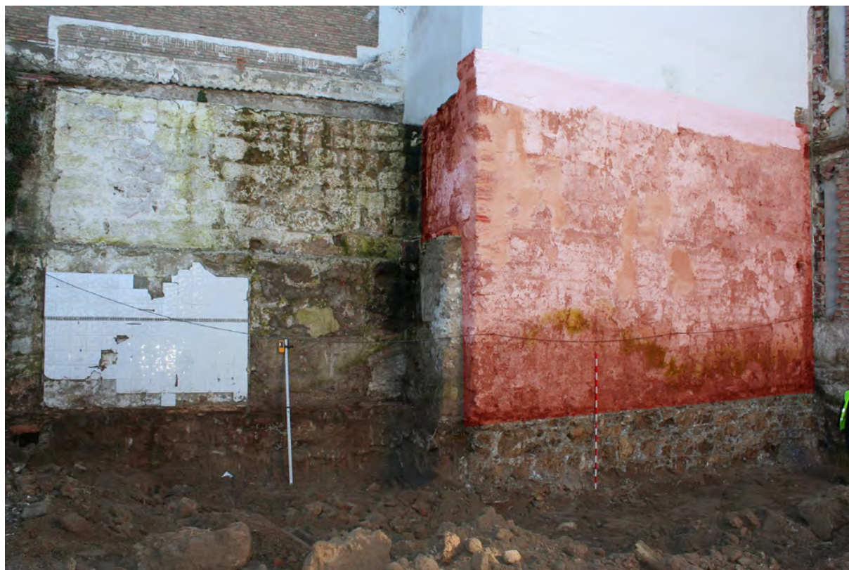
C/ Ribera de Molinos, 6. Refacción del muro de contención del patio bajo de Carnicerías (en magenta).
