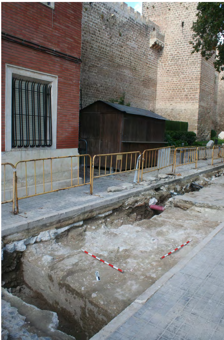
Zanja para instalaciones eléctricas. C/ Abad Palomino. Muralla de tapial hormigonado (torre) de época almohade (siglos XII-XIII) en su contexto urbano.
