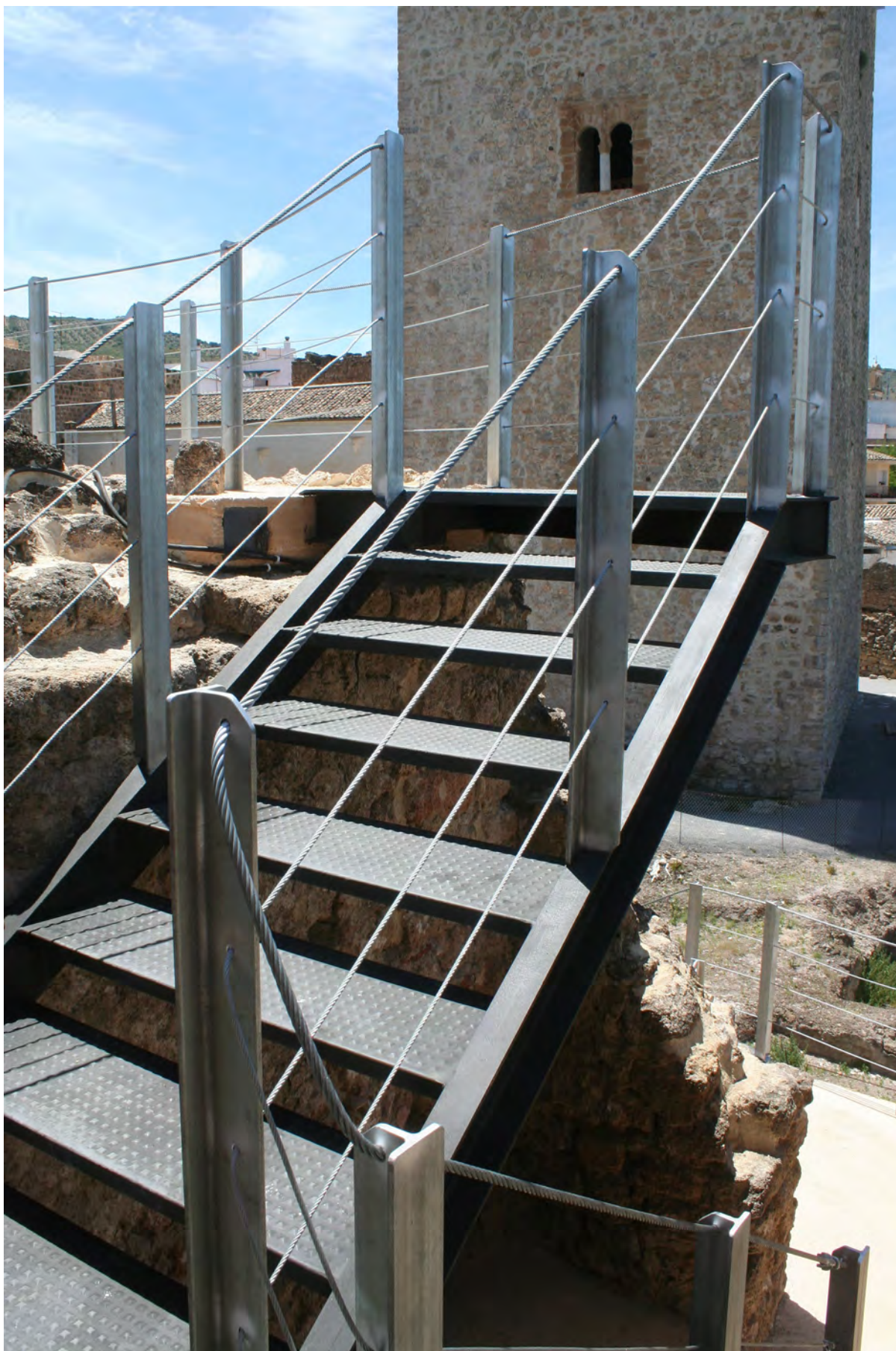
Castillo de Priego. Mejora de acceso a zona de adarves.
