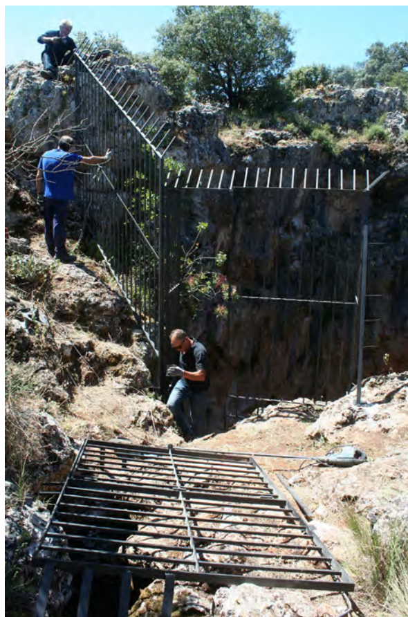
Cueva de los Mármoles. Instalación de reja.
